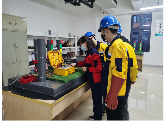
供配电综合实训室
